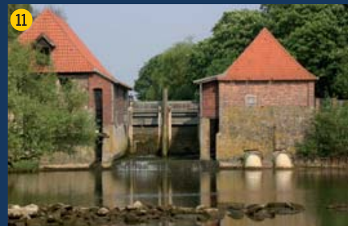
Die Füchtelner Mühle – malerisch und im Nebenfluss als kleines Wasserkraft-Werk genutzt. Durch den Bau einer Umflut ist hier 2015 die Durchgängigkeit der Stever für wandernde Fische wieder hergestellt worden.
